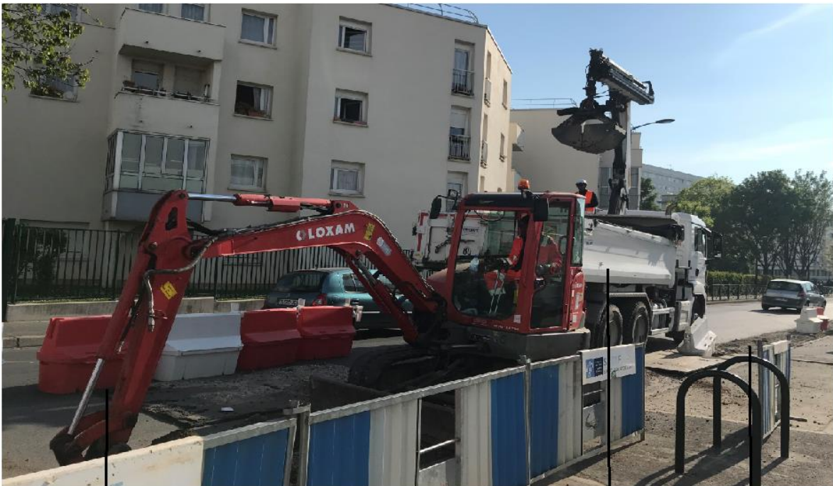
Mini pelle qui terrasse la tranchée sous l'enrobé (déjà rabottée)
